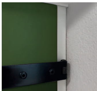
Bandella interna fissata su telaio
