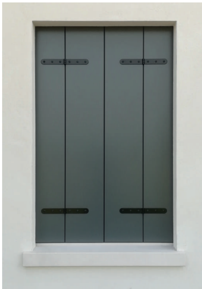
Bandella interna fissata su telaio
