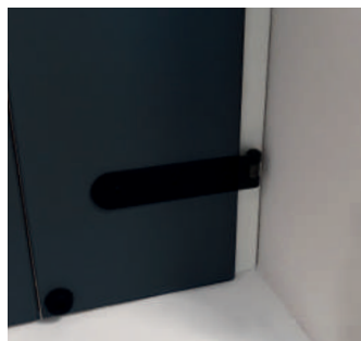
Bandella interna fissata su telaio
